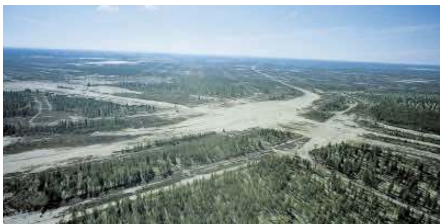
RUSSIA La giunzione di un gasdotto nei pressi di Nadym. (Foto di Armin Linke)
